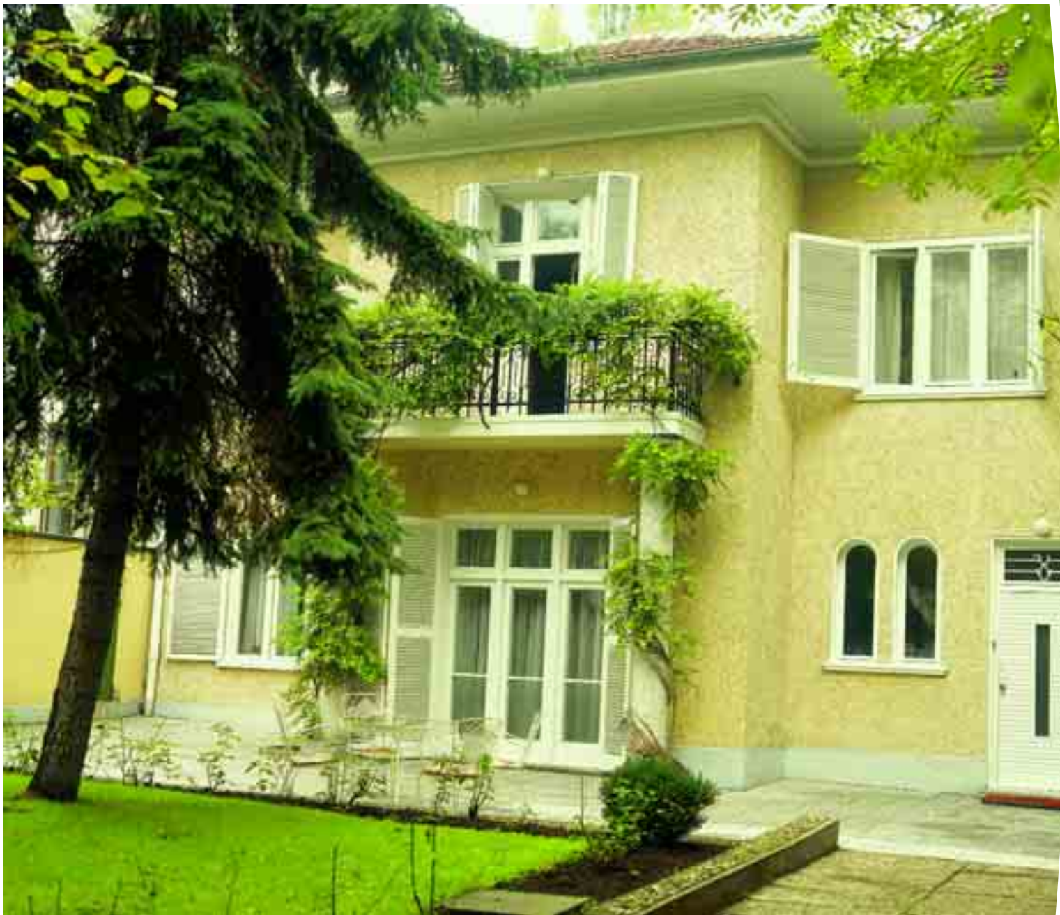
Предна фасада, официален вход, южно изложение Front facade, official entry, south view
